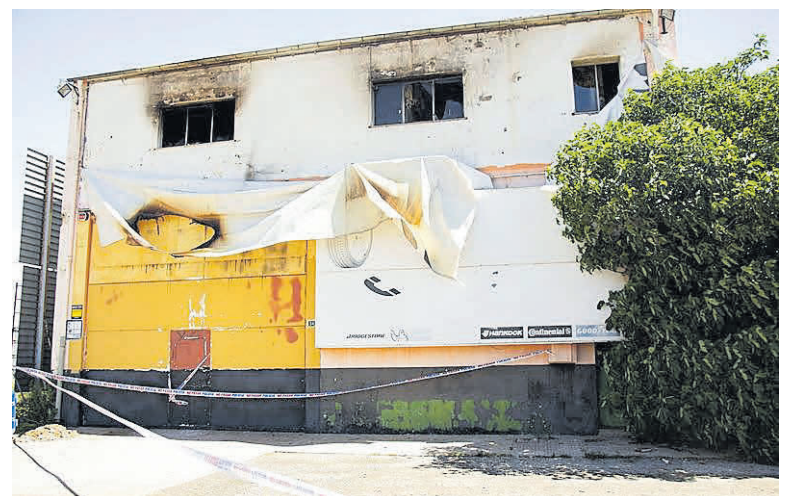
Imagen de la fachada principal de la nave. / MARTA HERREROS SÁNCHEZ
